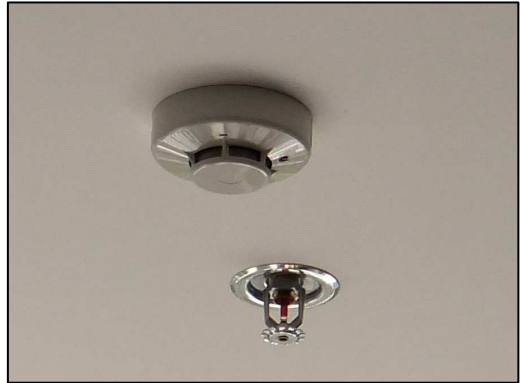
ภาพที่ 2-8 Smoke Detector & Sprinkler
