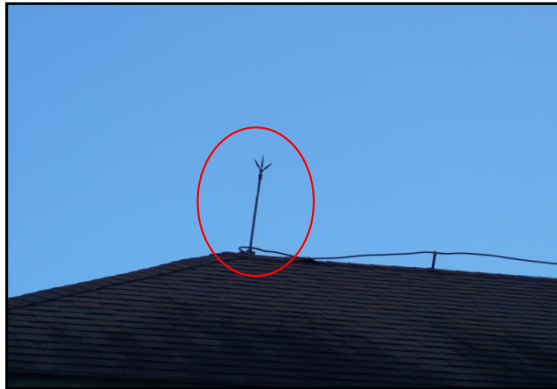
ภาพที่ 1-18 เสาล่อฟ้า
